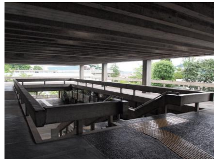
【図9】 倉吉市庁舎市民ホール
