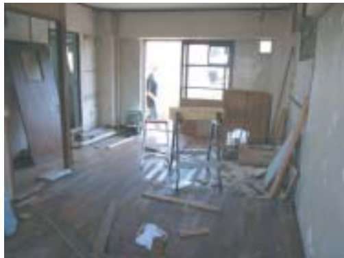
図4 改修工事中の住戸
