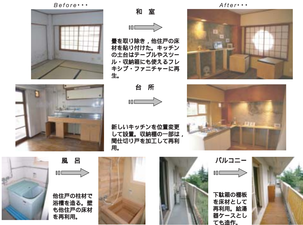
図7 リユースにより改修した住戸の前後
