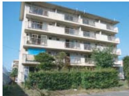
図1 実験の舞台となった西武庫団地31号棟
