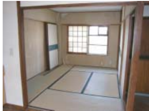
図3 改修前の住戸内
