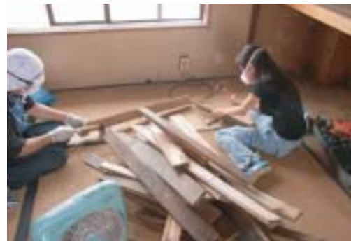
図5 解体した床材からの釘抜き作業
