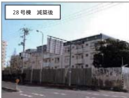
図11 上部2層減築による外観の変化
