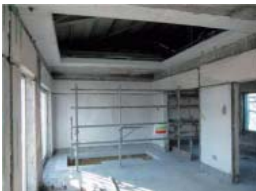
図7 床・天井スラブへの開口部の新設 (27号棟)
