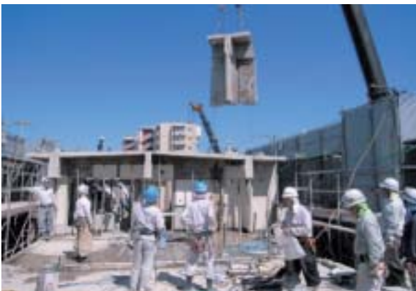
図9 減築中の施工現場(28号棟)
